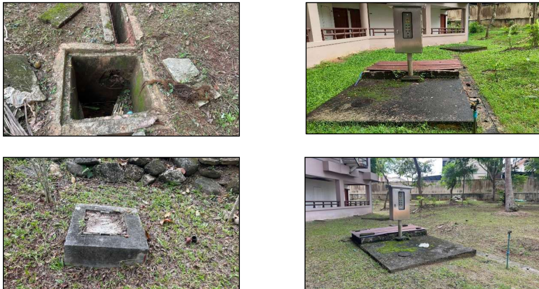
รูปภาพที่ 3.5.4 ป่อเกรอะและบ่อรวมน้ำเสีย
