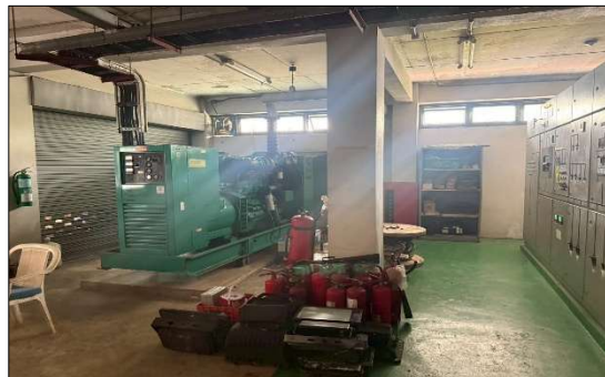
รูปภาพที่ 3.7.1 หม้อแปลงไฟฟ้า เครื่องสำรองไฟฟ้า ตู้ควบคุมไฟฟ้า
