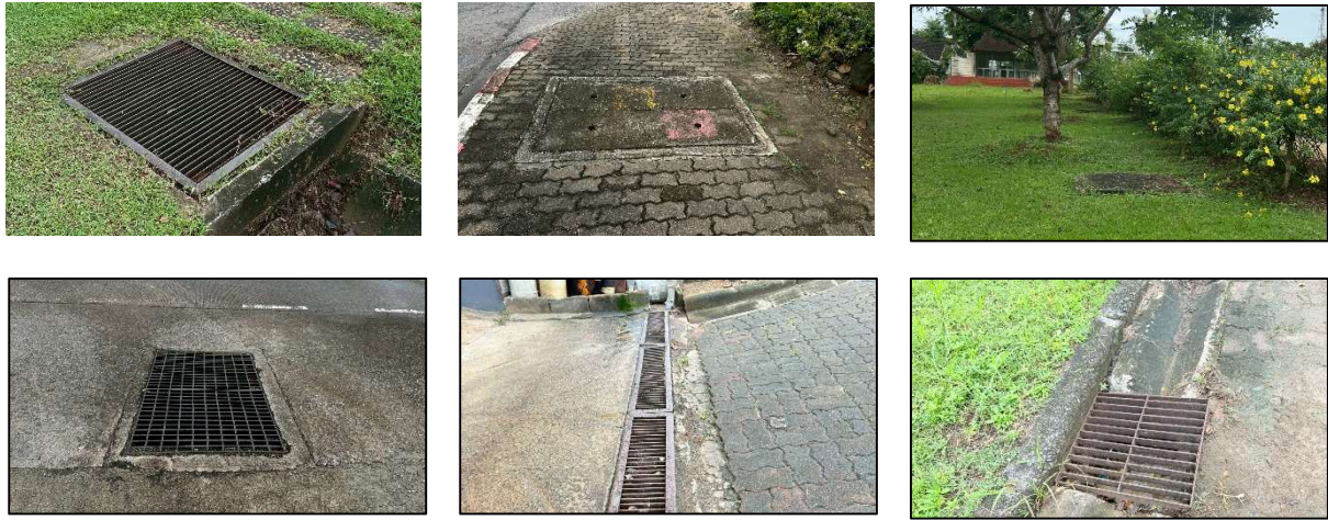
รูปภาพที่ 3.4.2 ตะแกรงดัักขยะก่อนที่จะระบายน้ำฝนออกนอกบริเวณโรงแรม
