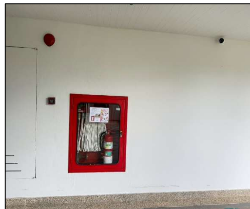
รูปภาพที่ 4.2.3 ชุดตู้ดับเพลิง (FHC)
