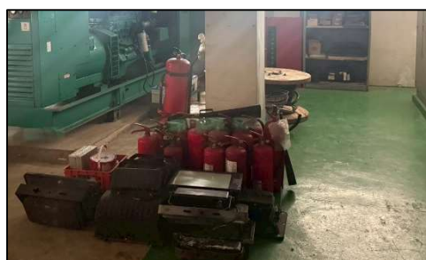
รูปภาพที่ 4.2.4 ถังดับเพลิงชนิดผงเคมี ชนิดน้ำยาเหลวระเหย และชนิดโฟม
